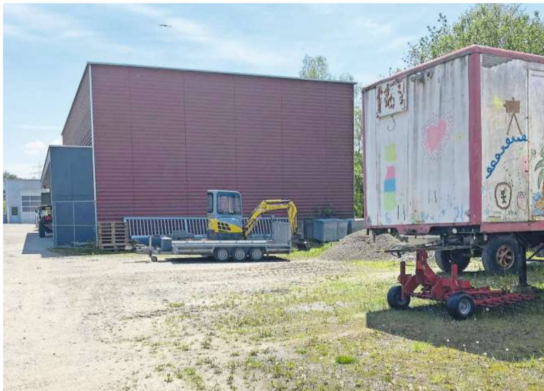
Auf der Moosmatt in Arni wird ab dem kommenden Frühling die neue Trainingshalle gebaut.
